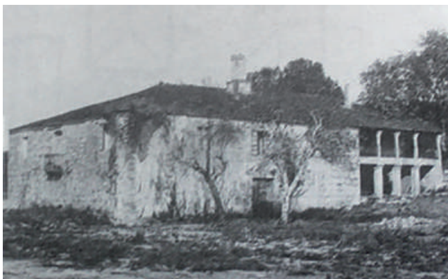
Fachada leste da casa de don Francisco Bernardo de la Vega Montenegro, en Santa Mariña de Cabreiros (foto da década dos anos 70 do século XX)
