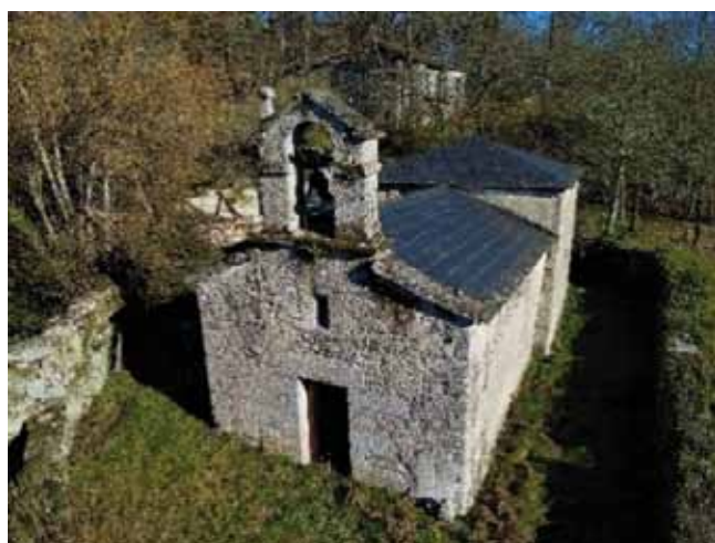
Perspectiva aérea da Capela de San Bartolomeu
