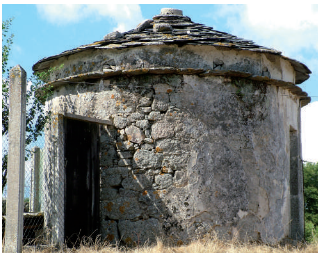
Imaxe 6.1. Pombal da Casa de Somoza (foto feita en 2008)
