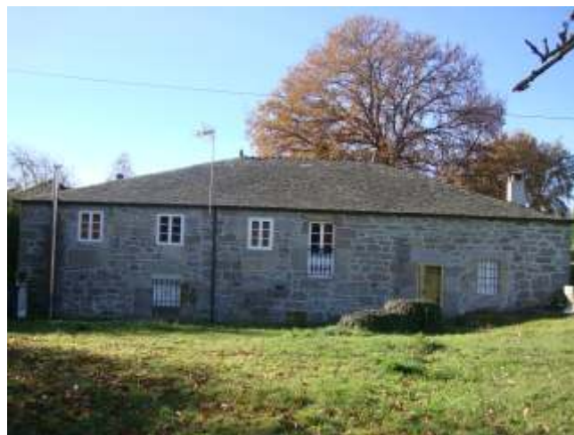
Casa de Trebolle
