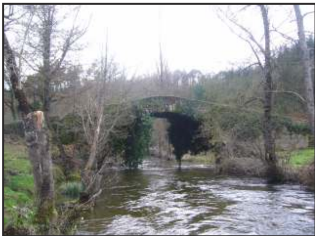
Foto. Ponte lago
