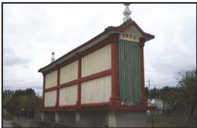
Fig. 37 - Hórreo de formigón sobre cepas
