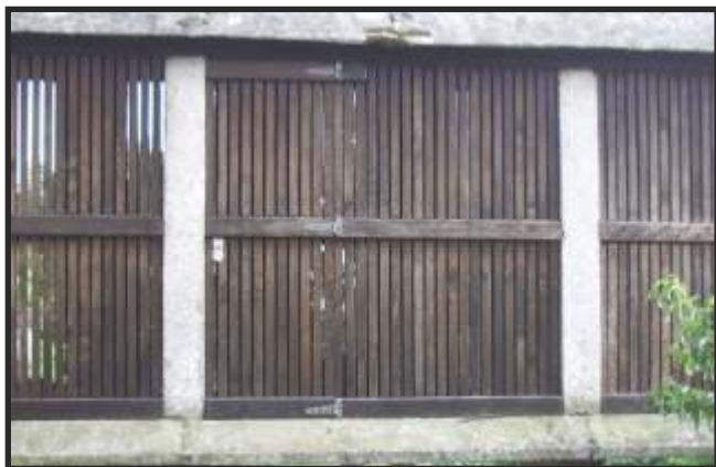
Fig. 15 - Doelas de madeira e estrutura de pedra
