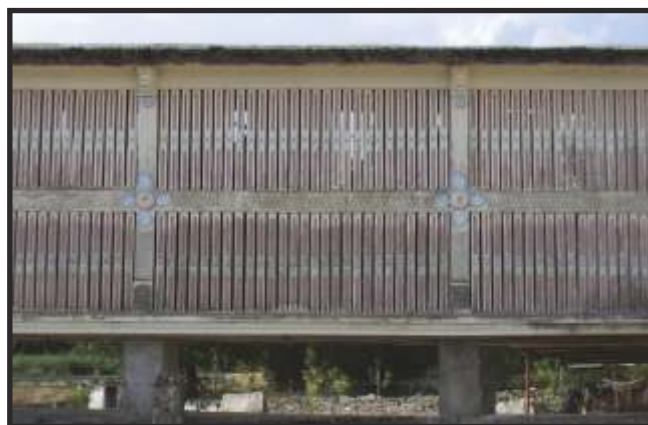
Fig. 17 - Doelas e estrutura de formigón
