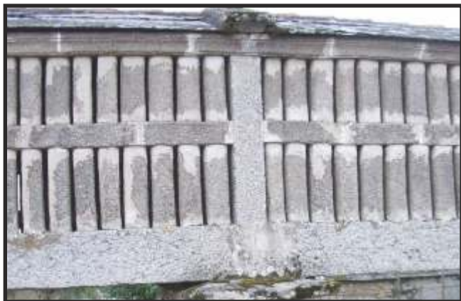
Fig. 16 - Doelas e estrutura de pedra
