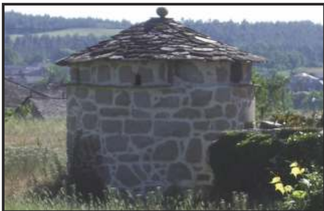
Fig. 4 - Pombal de cachotería de granito
