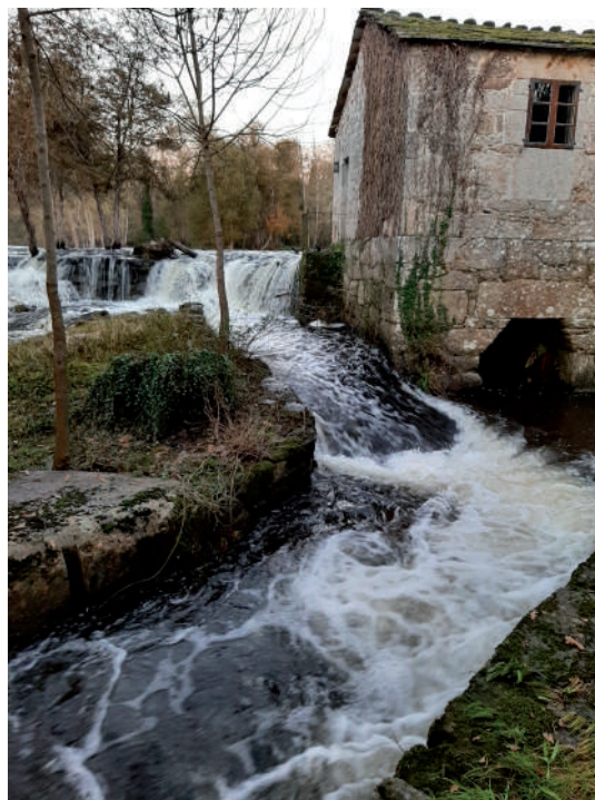
Imaxe A2.1. Posibel emprazamento das arcas da Fervenza
