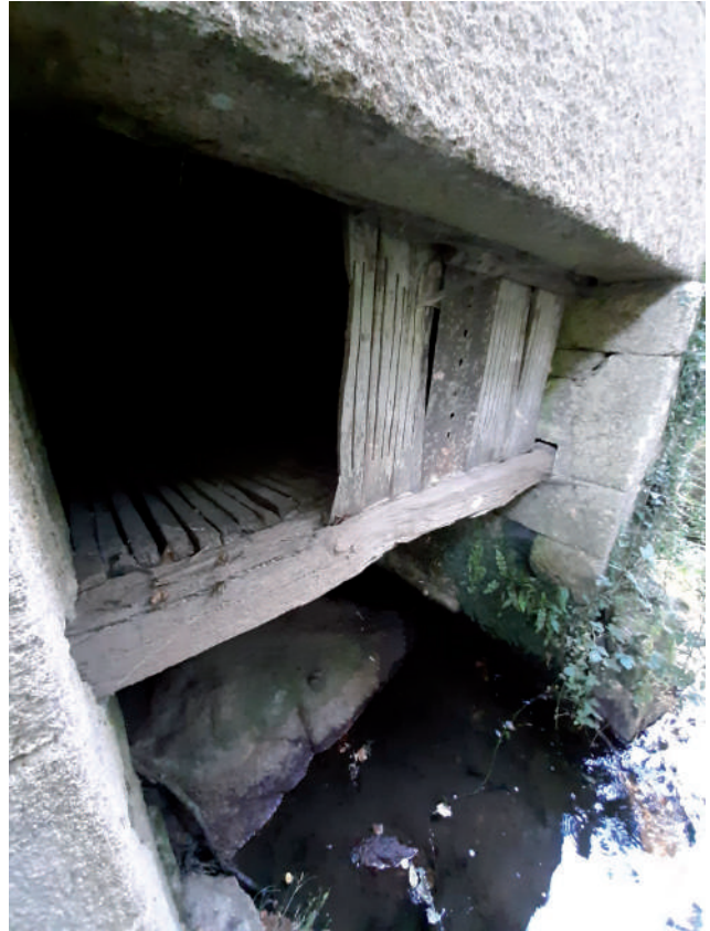
Imaxe 4.1.3. Foto do final da arca situada no muiño de Paz onde se poden ver as doelas de madeira da grada
