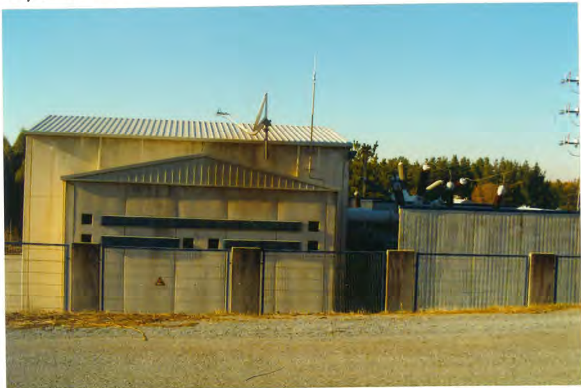
F 24- Subestación de Folgosa
