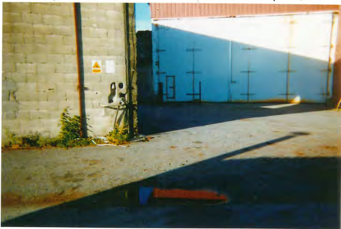
FBO. Cámara de secado en la tierra de Eduardo Campo
