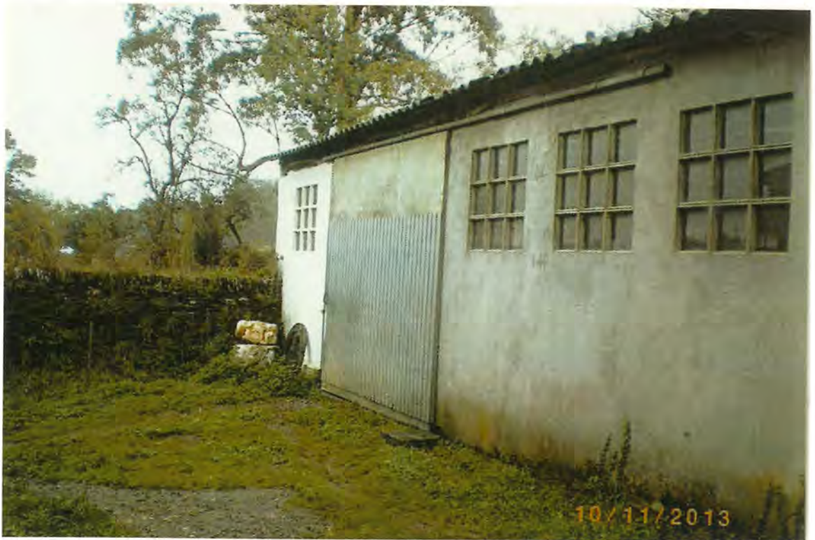
F. 58 - Nave maquinaria agrícola, en Folgoza
