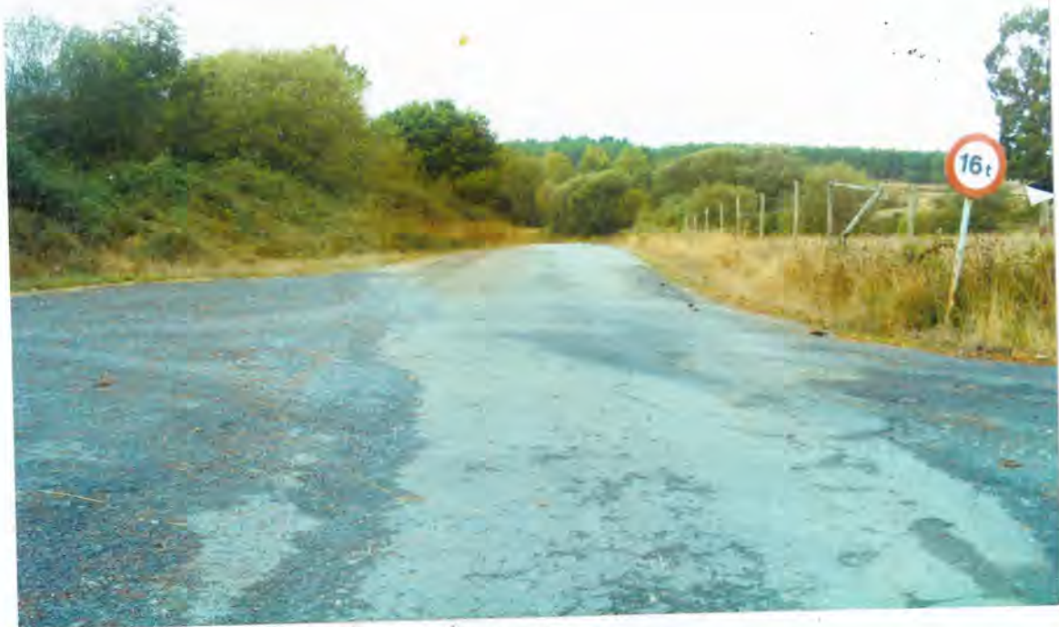
F. 45. Carretera de Marey a Ansean
