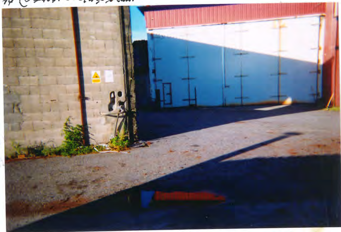
f58 - Cámara de secado en la sierra de Eduardo Campo
