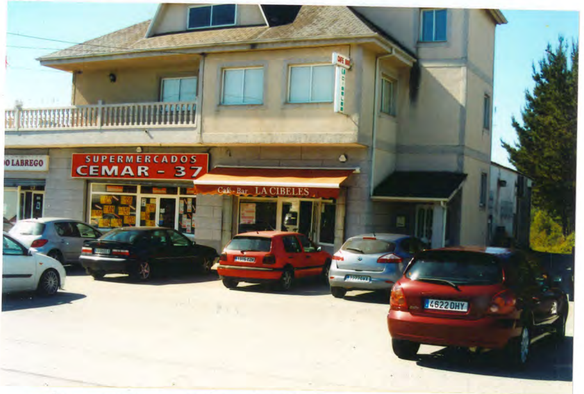
F49 Edificio -BAR LA CIBELES.
