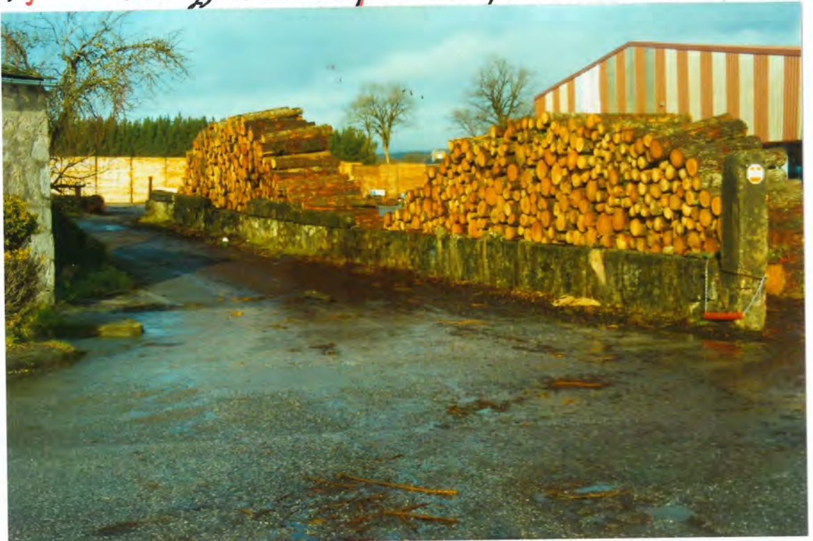
F.15.- Lugar de los mojones delimitando la "Plaza de Corgo", ubicada entre la N-VI- y el camino de las antiguas escuelas.
