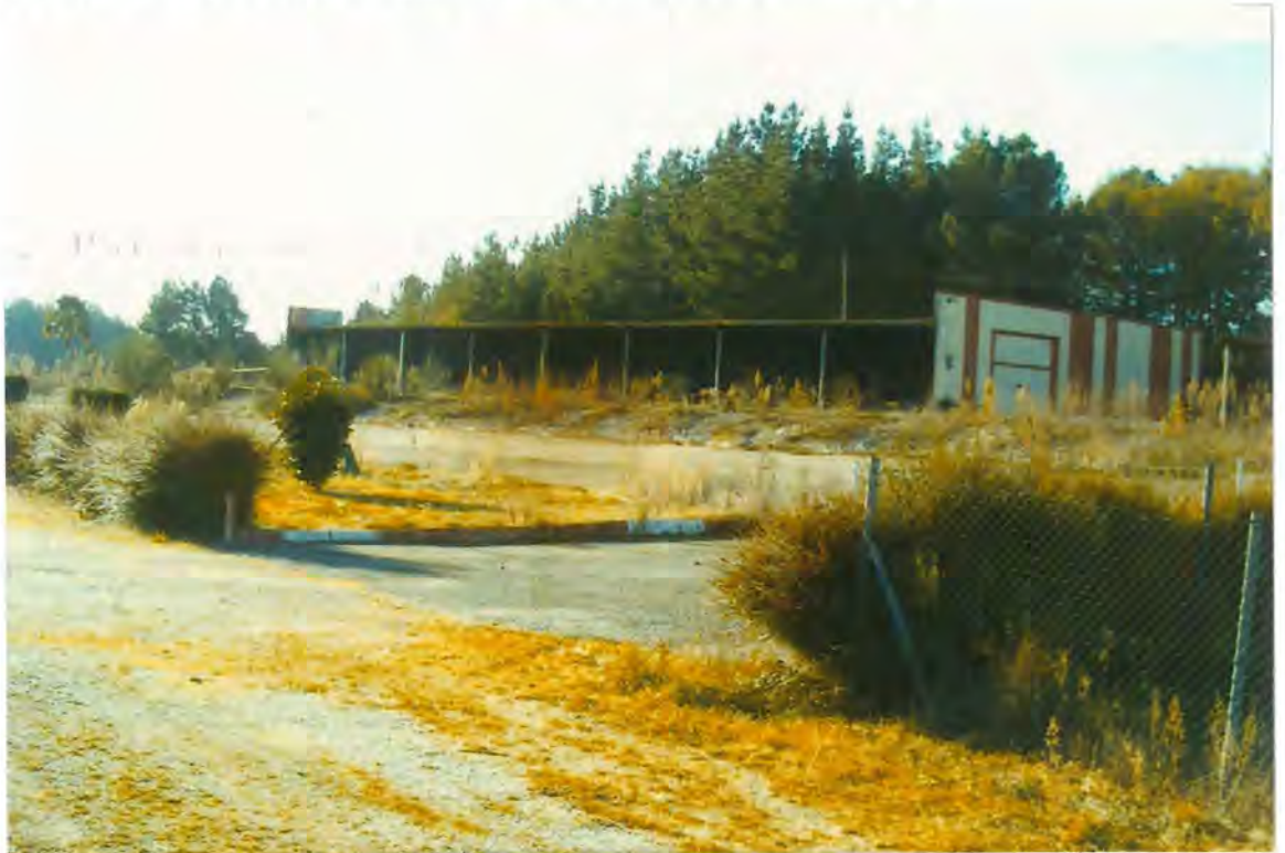
F27- Lugar donde estaba " Muebles Toirán S.L. ", antes del incendio.
