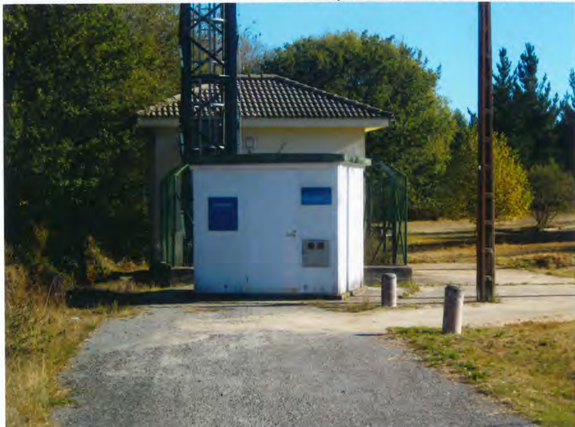
P 32 - Central de Abonados de Telefonos
