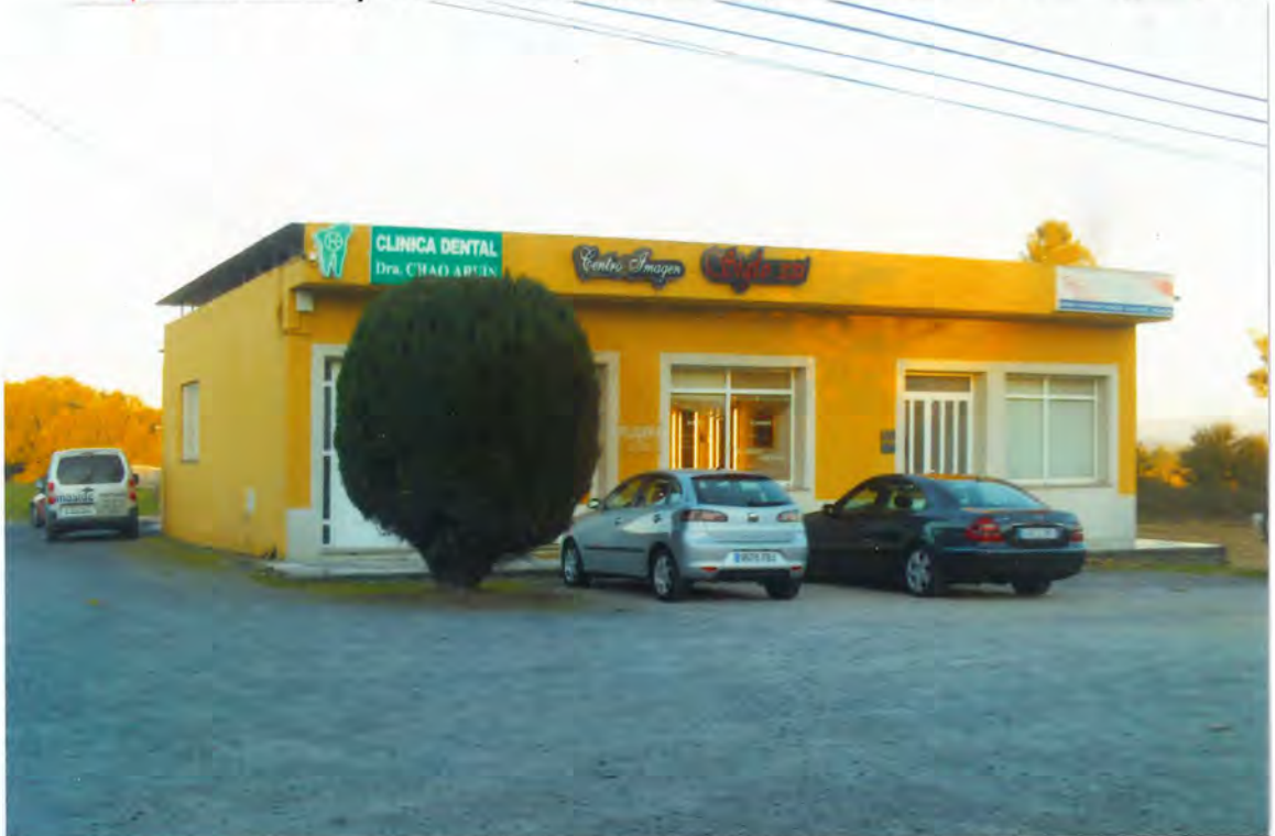
F20- Nave de Javier Vila Nuñez
