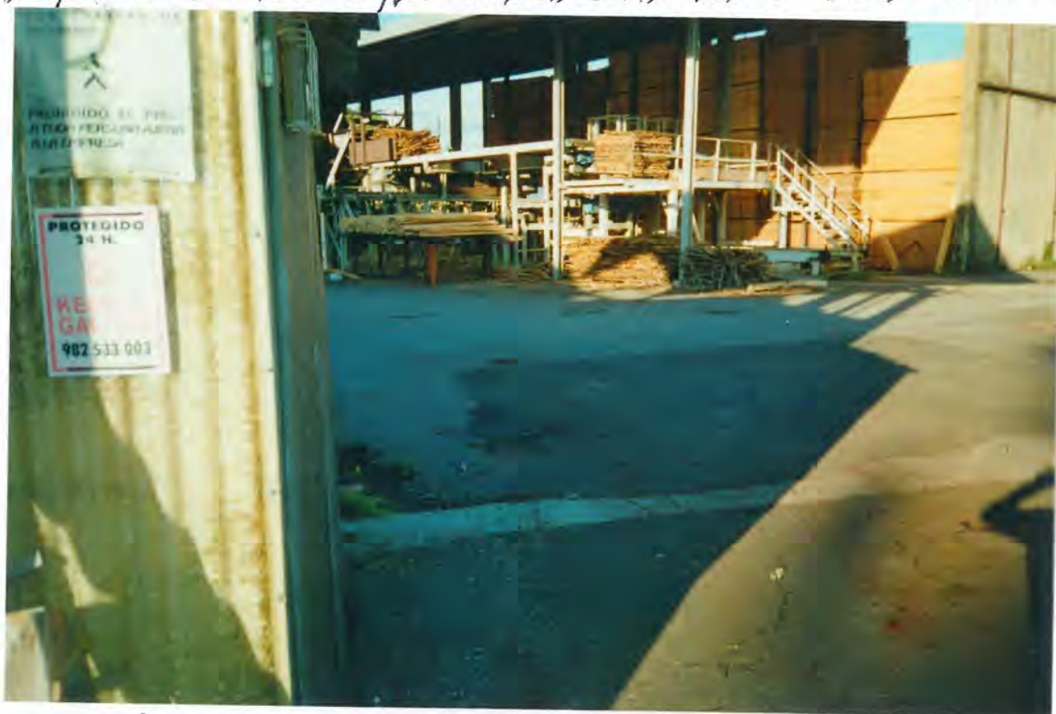
F5. Nave para la transformación de la madera
