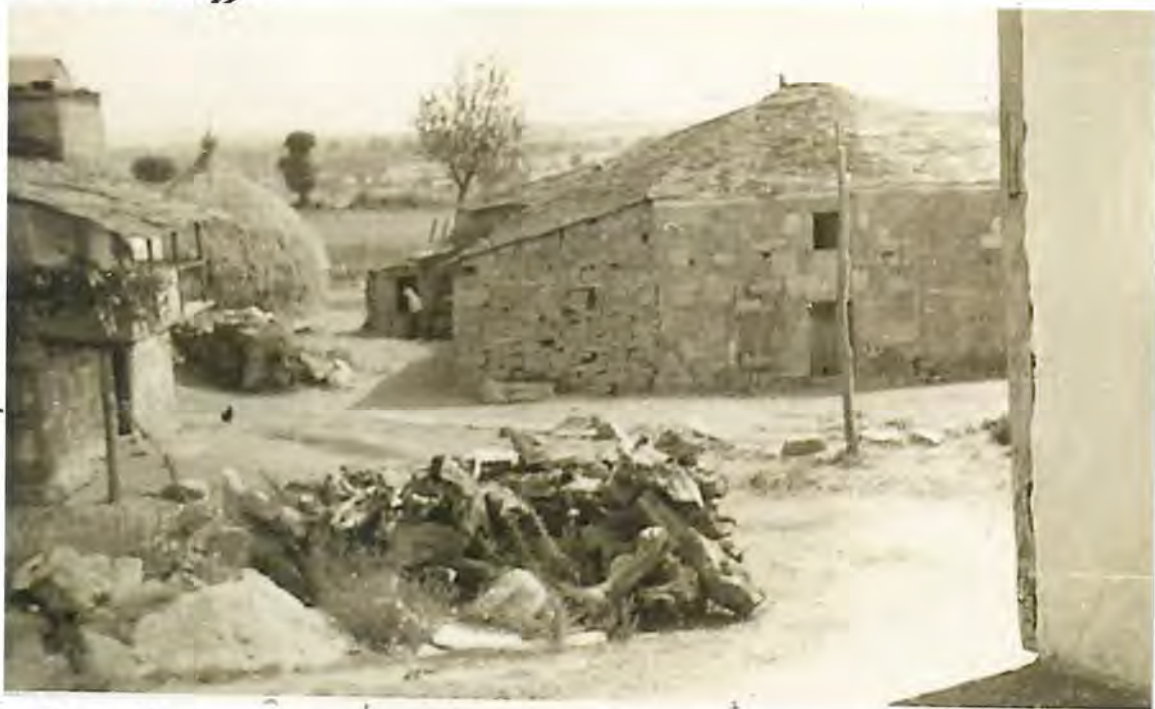
F56. Antigua casa conocida por "Zapateiro" que fue demolida por Eduardo Campo Seijas para la construcción de la Sierra.
