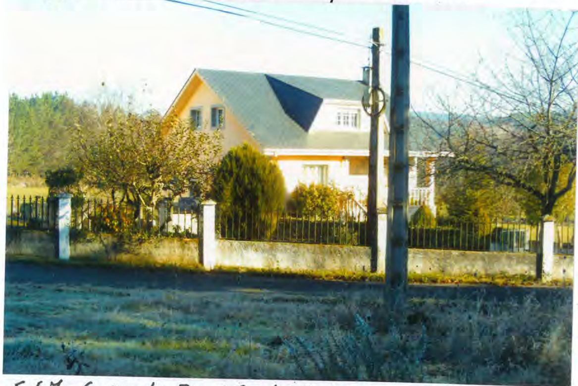
F. 67 - Casa de José Gude Tallón, en Fonteita
