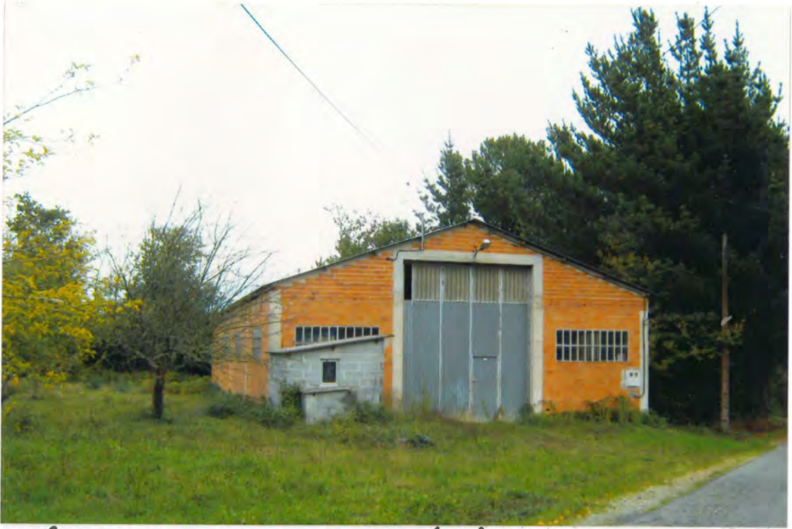
F 7 - Edificio de Manuel Parga Santiz, en Farnadeiras
