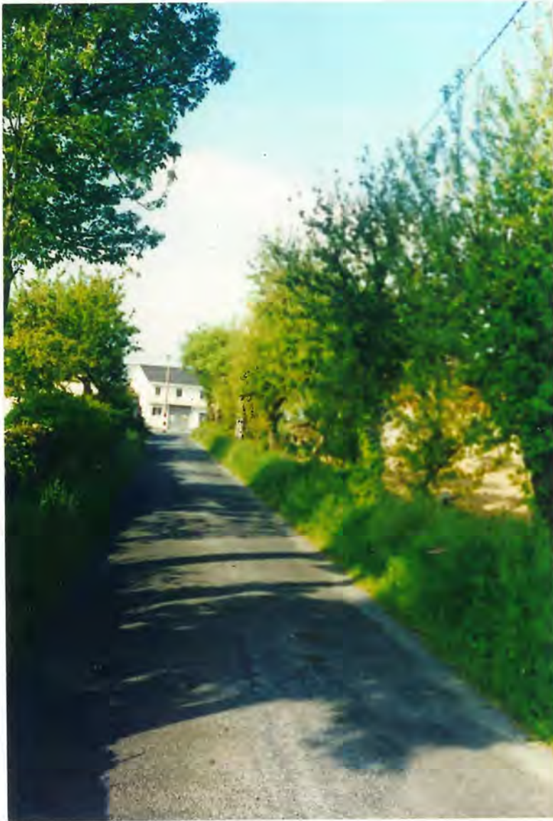
F 21-Carretera a Sanza de Bergazo, antes del ensanche
