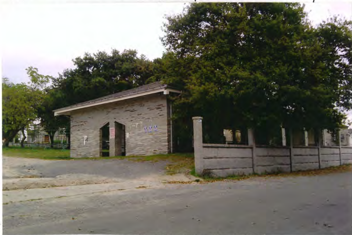
F55. Pabellón en el campo de la Feria de Aduy
