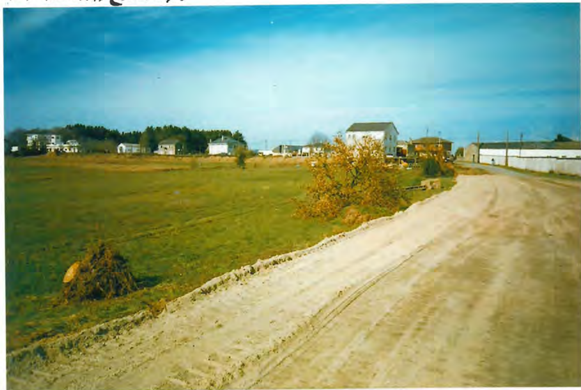
F. 63. Acceso a la Iglesia de Corgo, en obras
