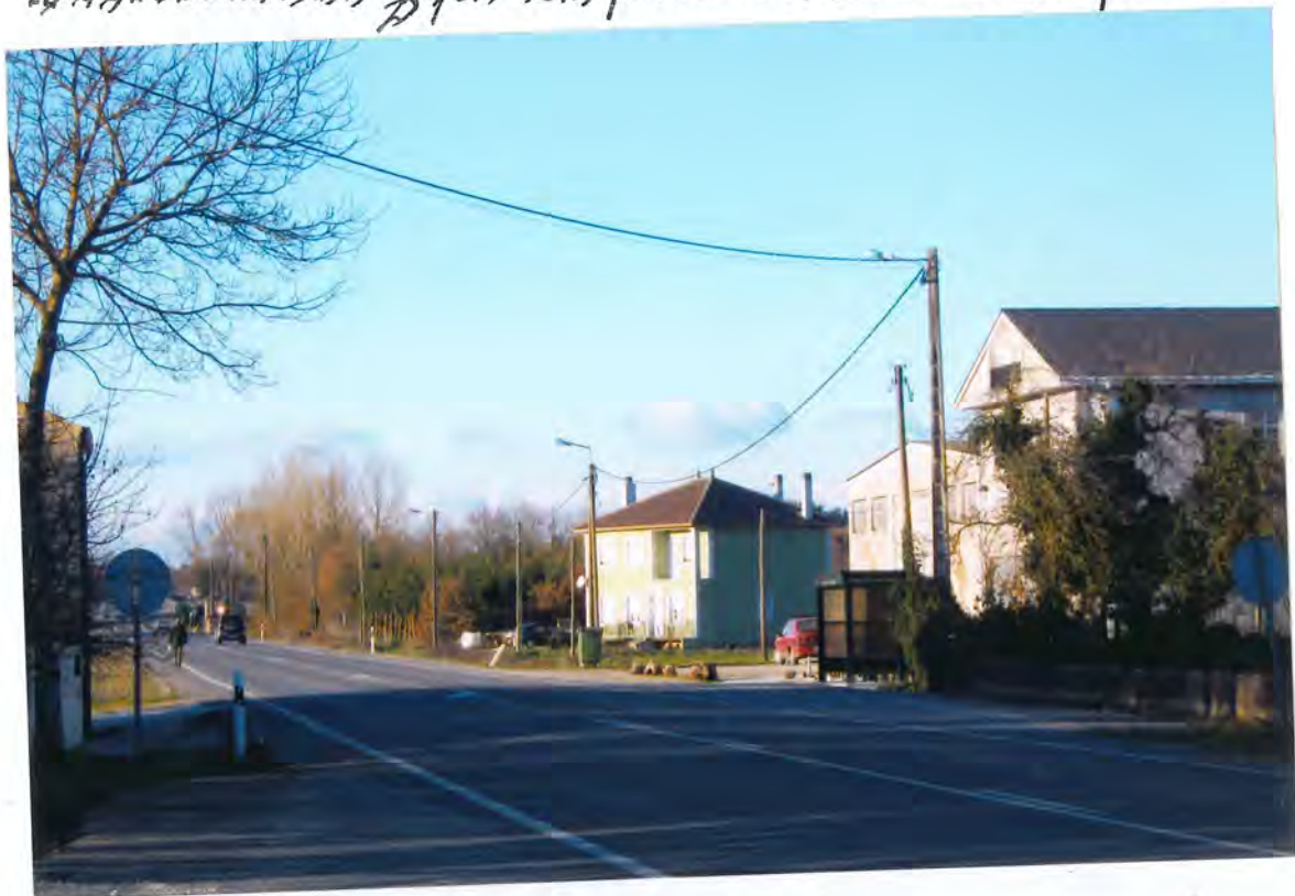
F15- Alumbrado público en Escoureda
