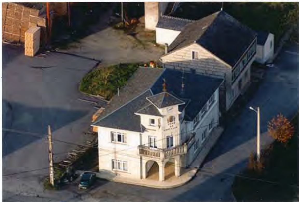
F40 - Vista aerea de la Casa Consistorial
