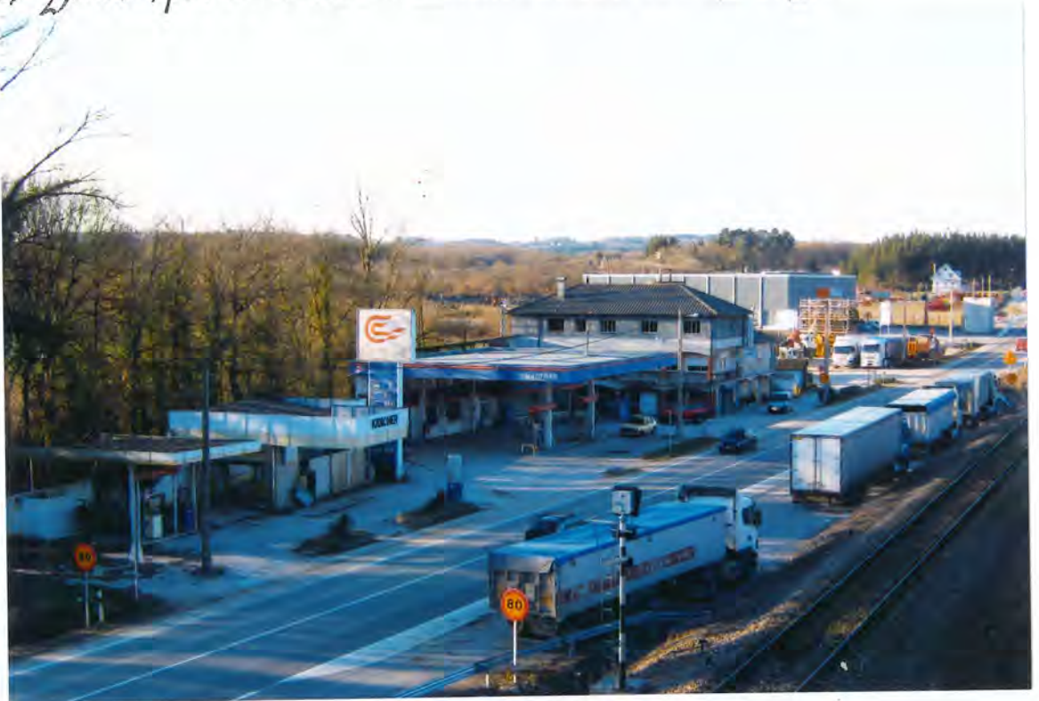
F14- Estación de Servicio en Maceda
