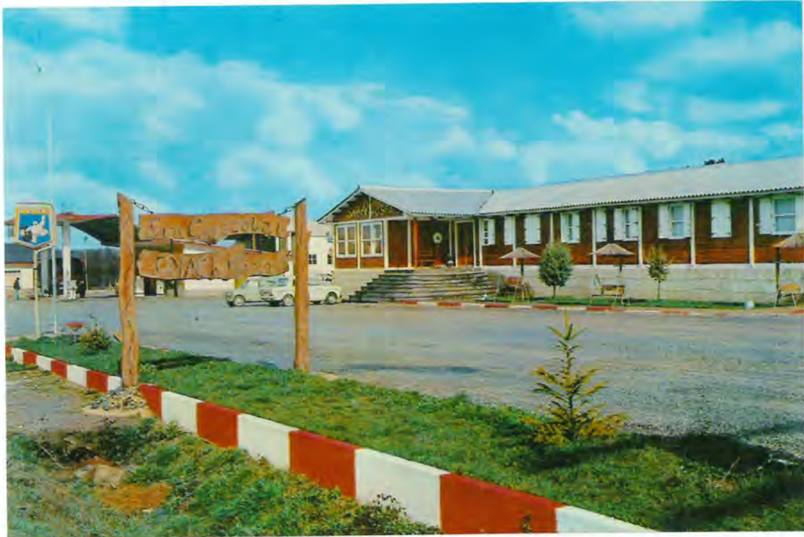
F. 23 - Estación de servicio de Lence en Corgo, que fue demolida la parte izquierda.
