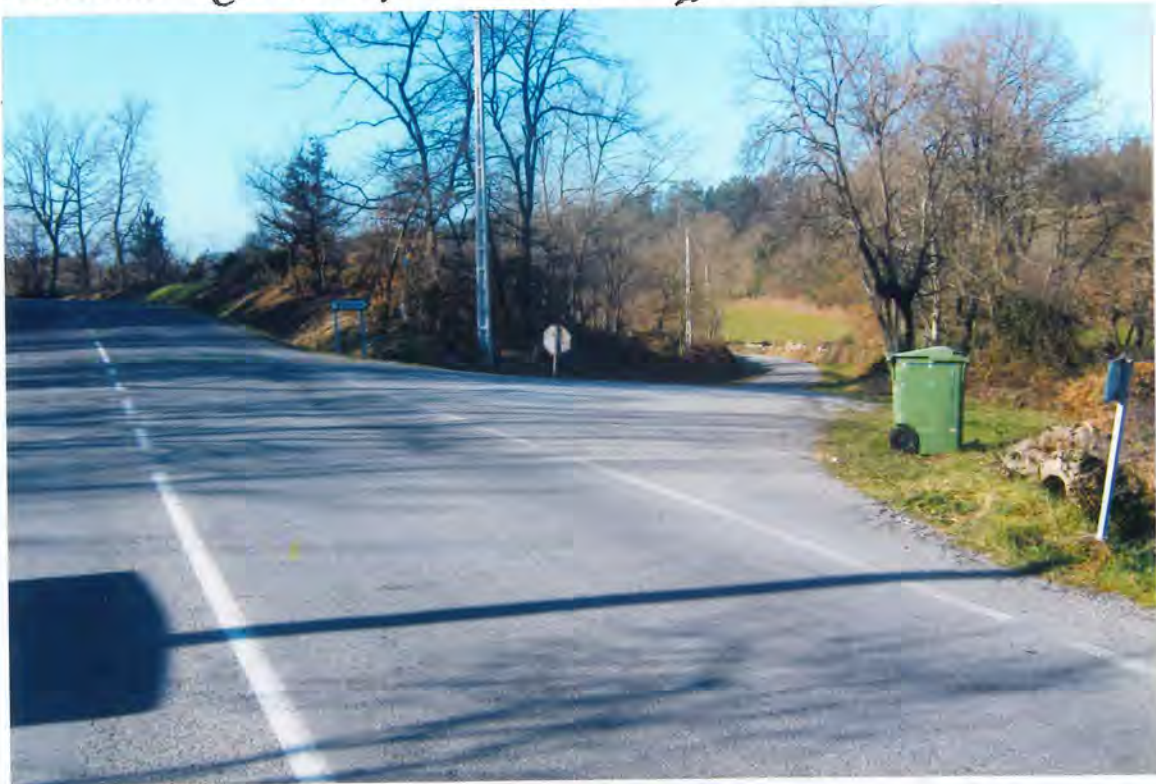
Fig- Enlace de la Carreta de Queizán, con la de Fonteita, en Mesón de Ramos
