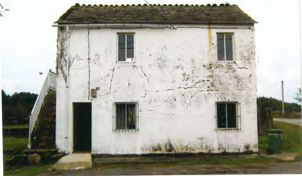
F. 60. Edificio de la antigua escuela de S.P. de Farnadeiros
