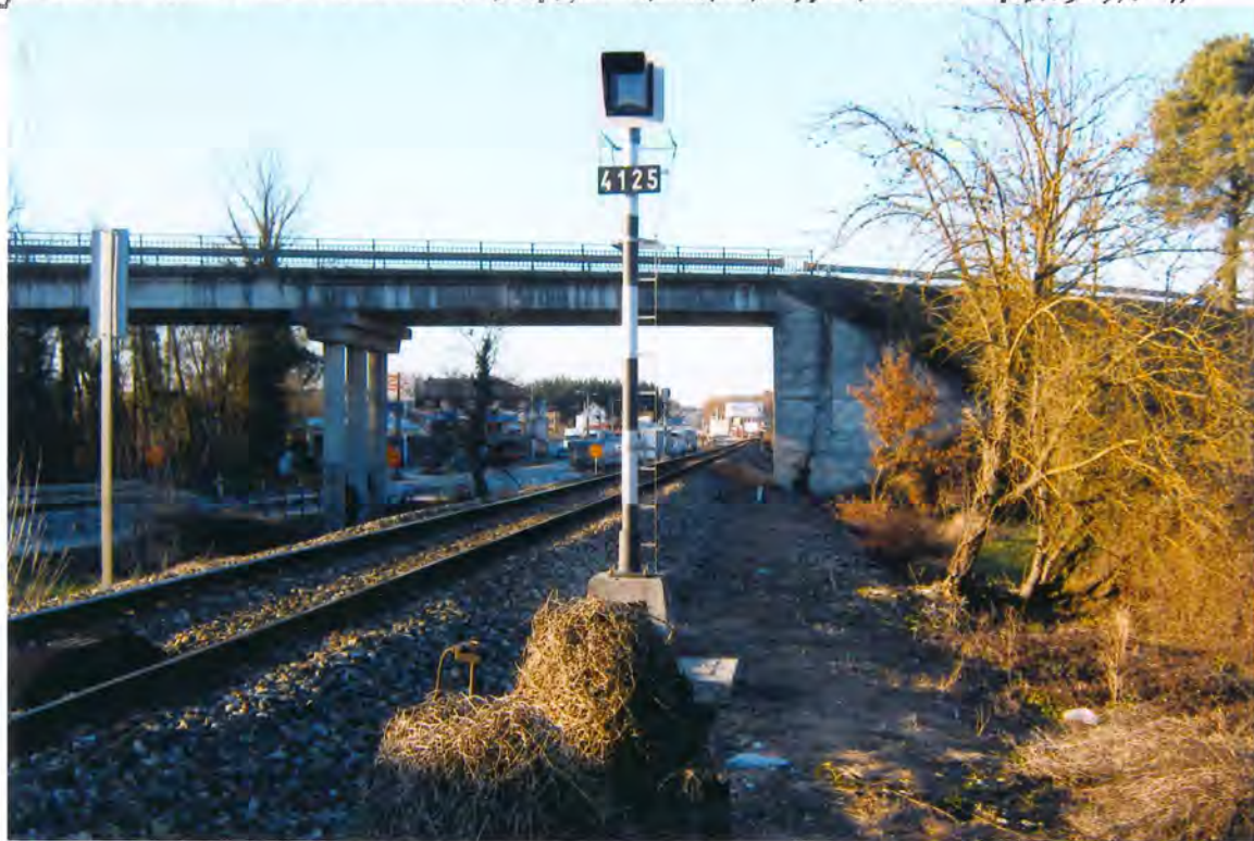
F35. Puente sobre el F.F.C.C. en Maceda
