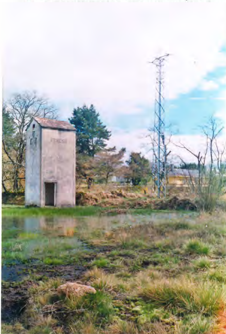
F 41- Caseta construida por el Sr. Tella para colocación de un interruptor automático de un equipo de medida de energía eléctrica
