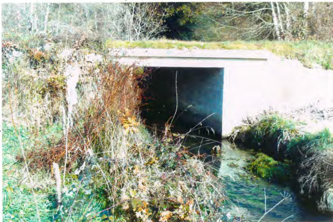
F.57 Puente Abeledo
