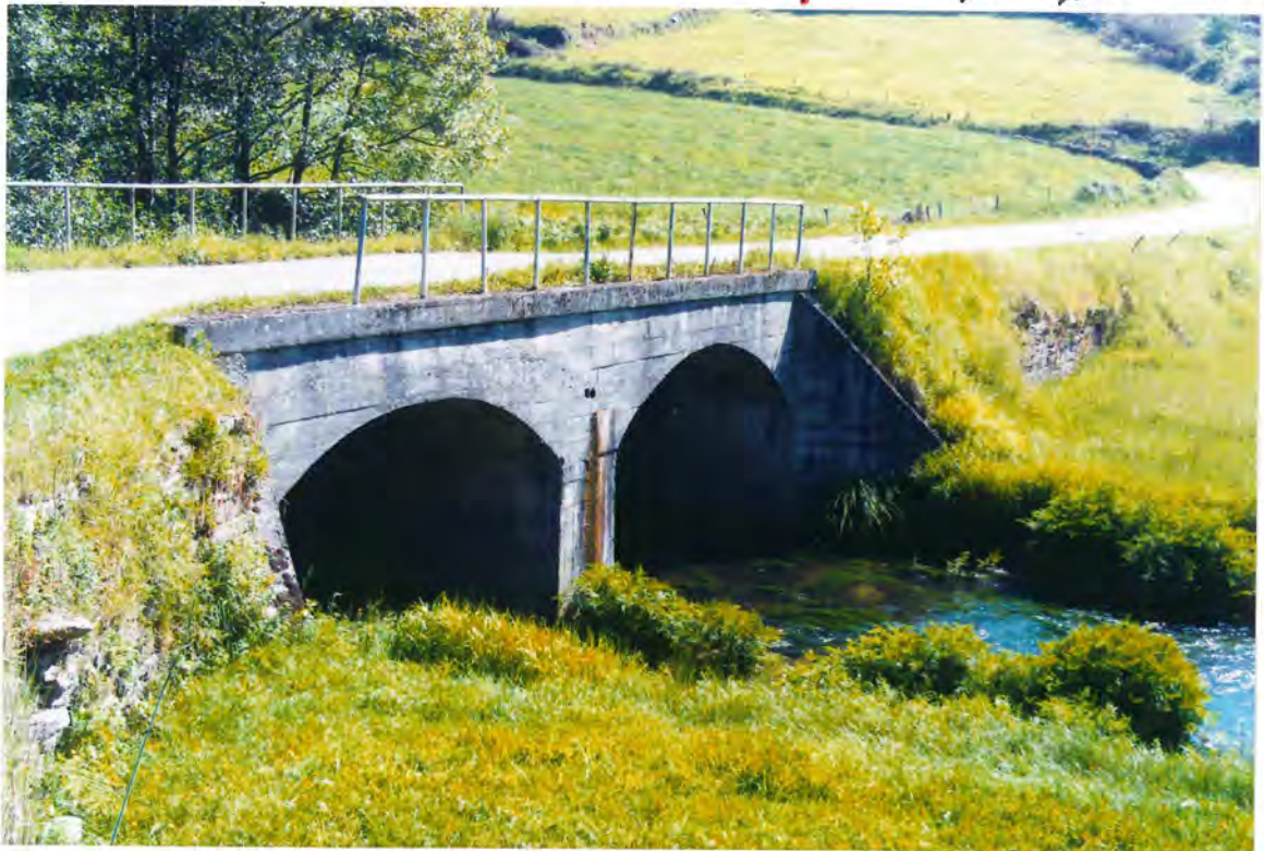
F 18. Puente de Vilanova-Marey
