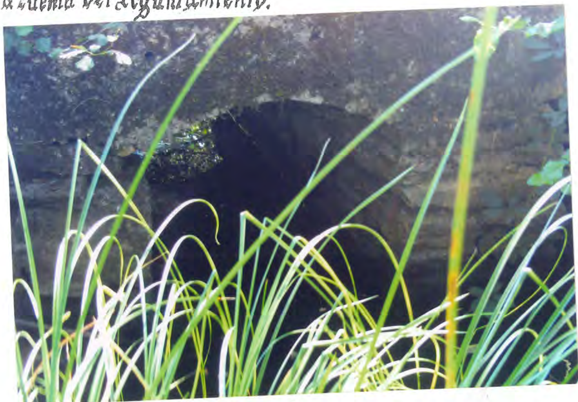
F22- Puente das Abelairas-Corgo
