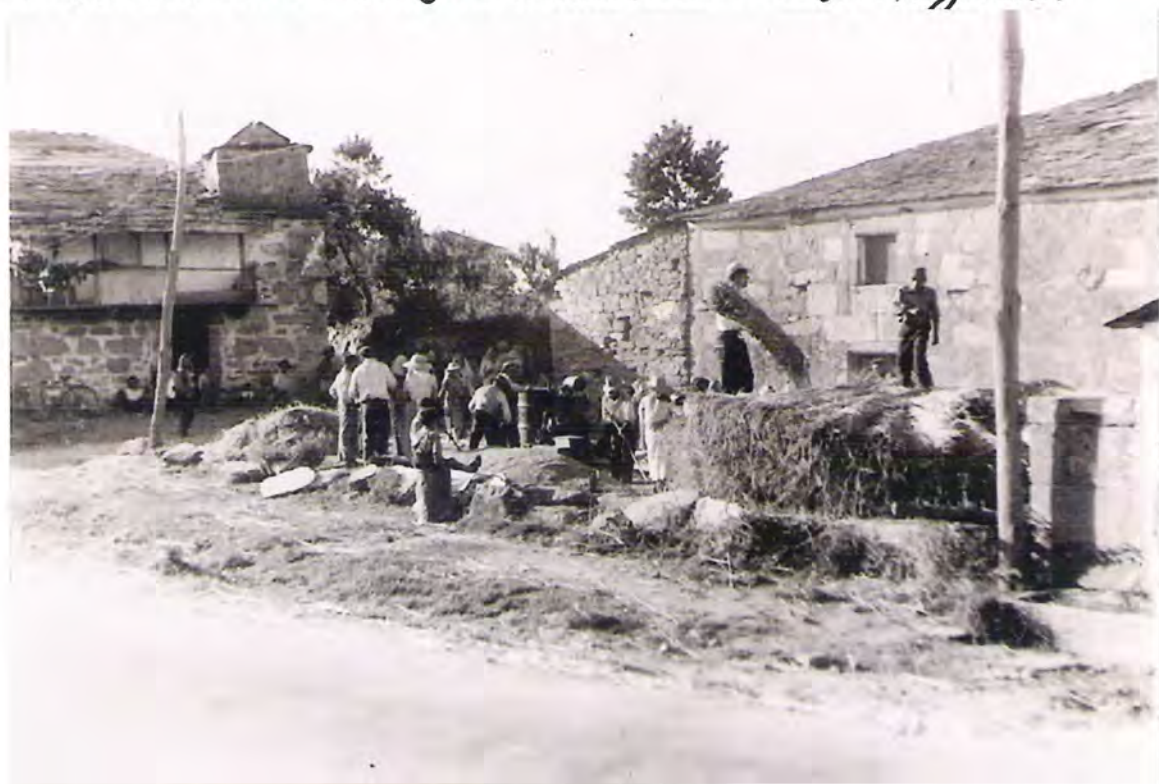
F-59 Casa conocida por "Zapateiro", donde estuvo instalada la Escuela de Niñas de Corgo.
