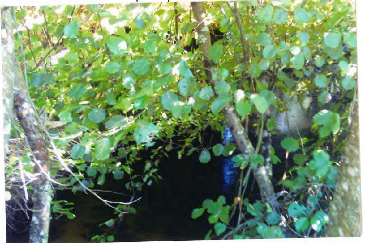
F.16- Puente de Leiras
