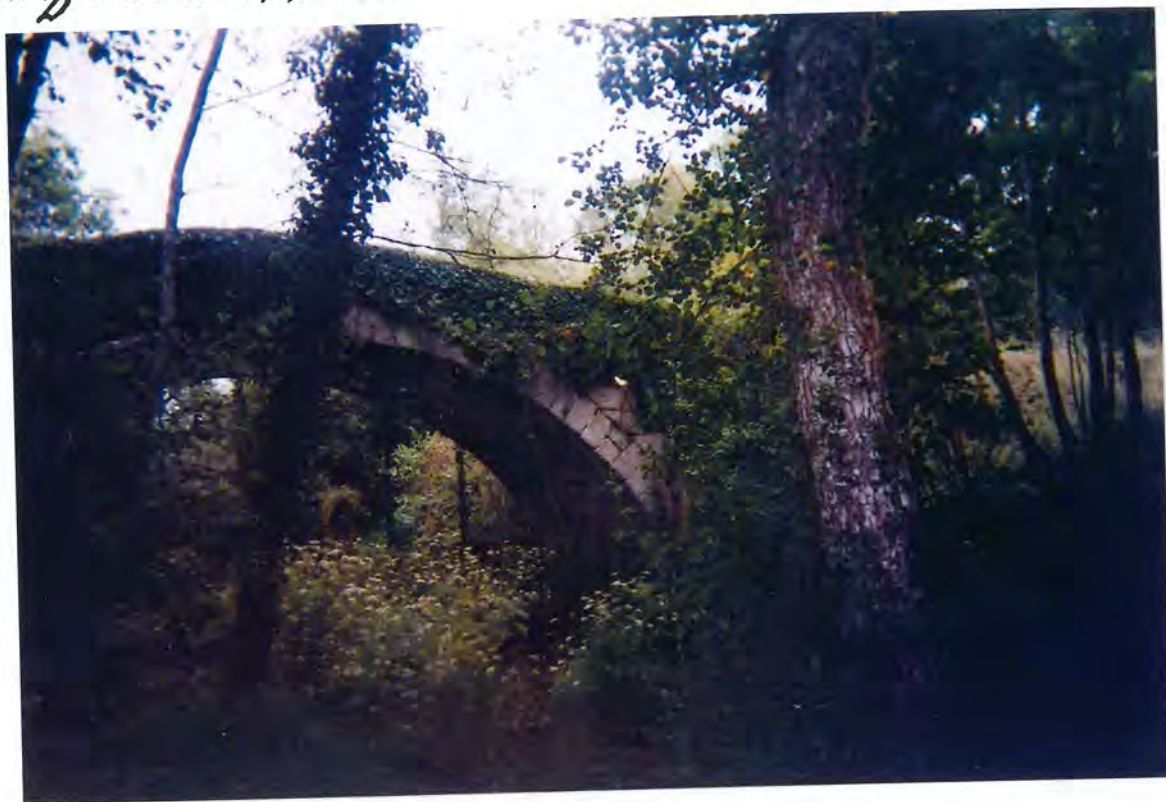
F. 49 - Puente de Galineiros
