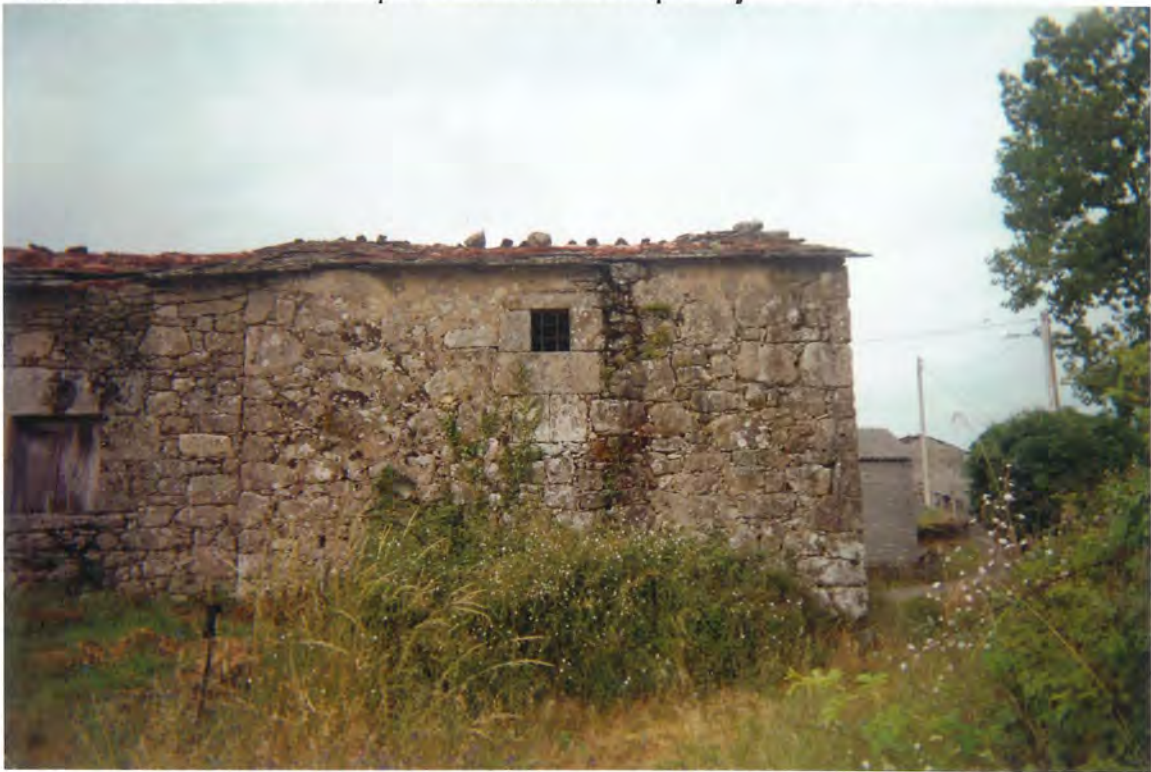
F.21. Edificio de la antigua "Carcel de Aday".
