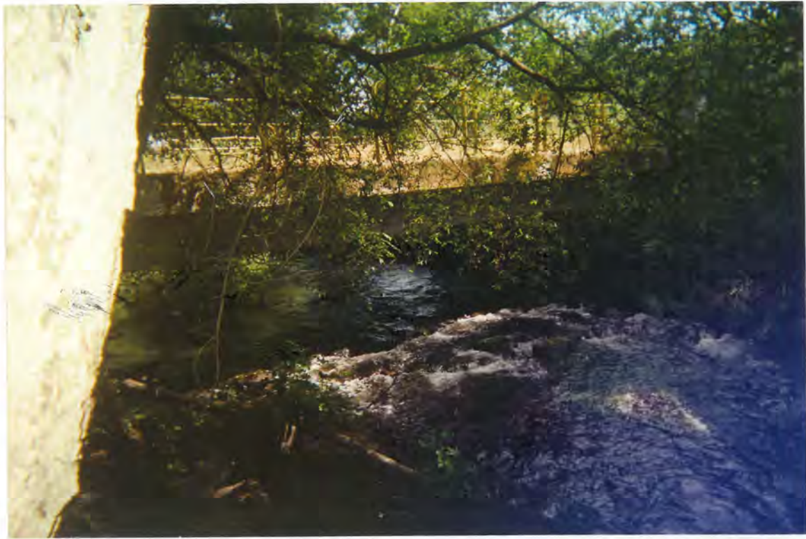
F.36. Puente sobre el Rio Tordea, en Escourada, lugar de Porto de Chousa
