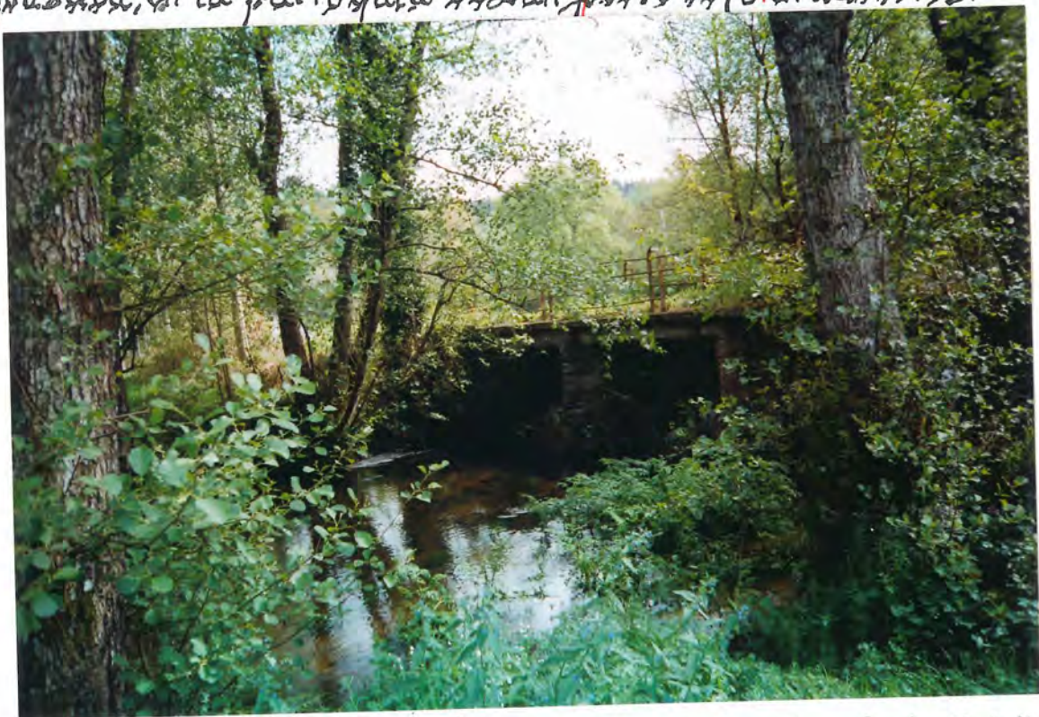
F4. Puente sobre el río Pequeno, en la carretera de Gomeán a Santa Eulalia del Alto, construido por acuerdo en sesión de 11-IX-1887 (pag. 328)
