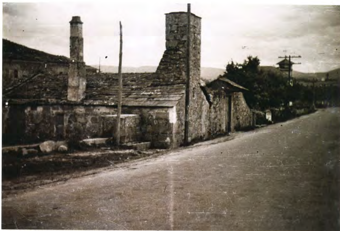
F.28. Edificio que fué de D. a Dolores Martinez, donde estuvieron instaladas las Oficinas del Ayuntamiento, desde el 9 de Octubre 1.862, al 26 de Abril 1.874
