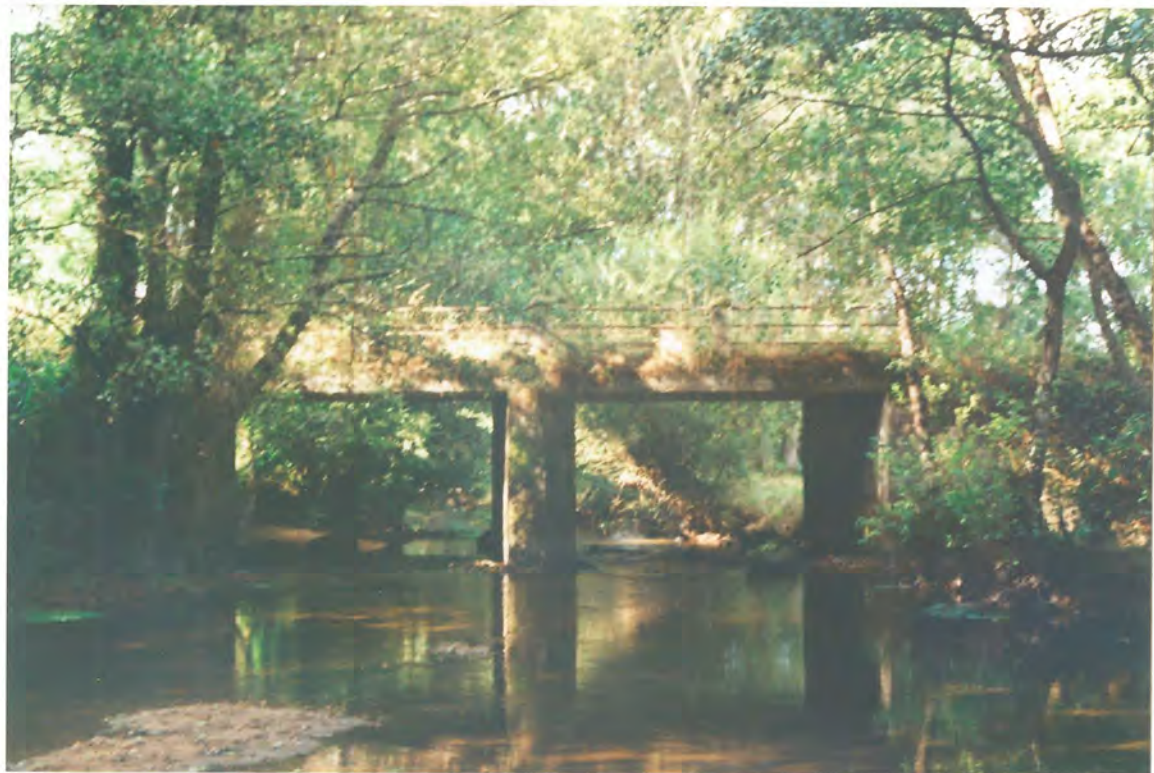
E.12. Actual puente, sobre el río Tordea, en Franqueán.
