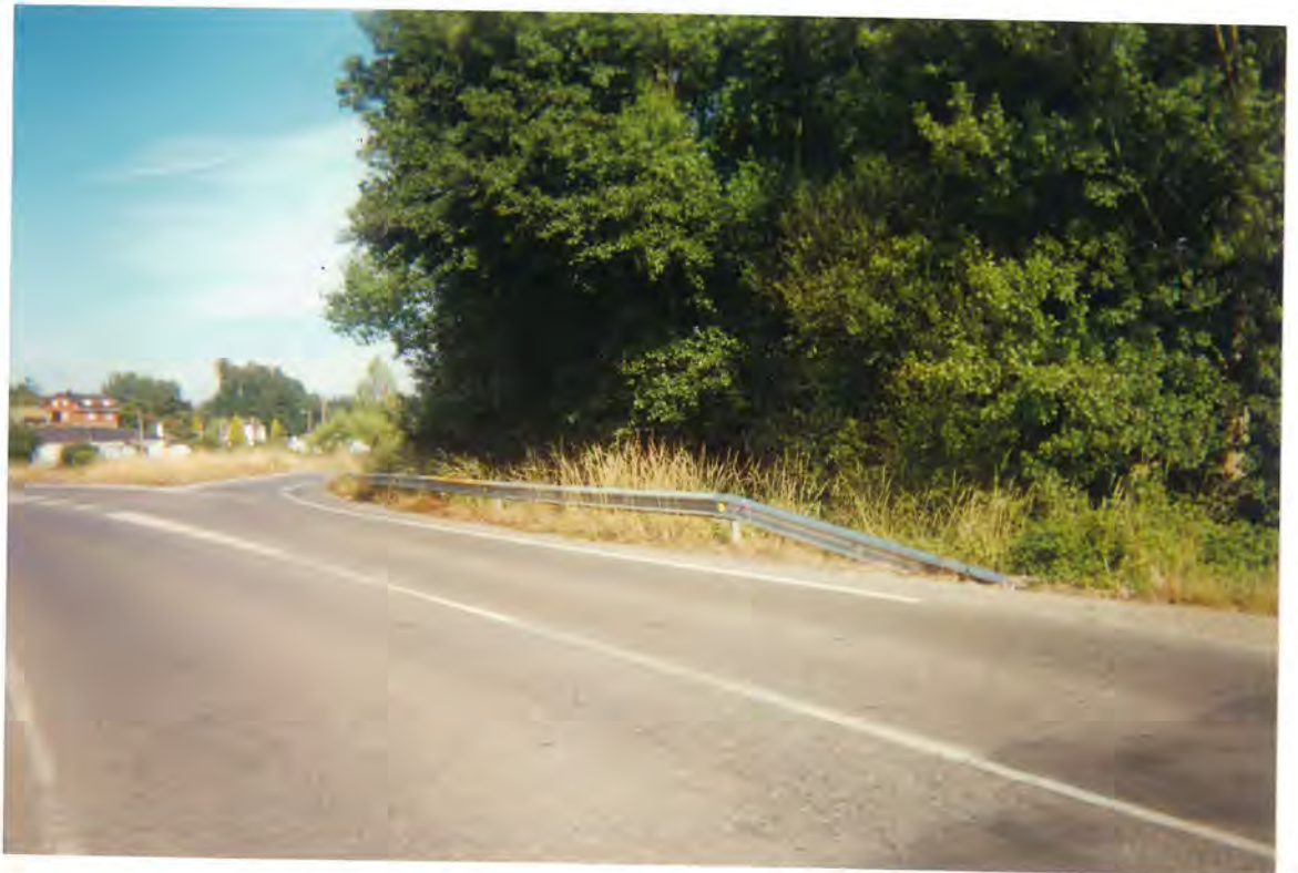
E14. Carretera de Maceda a Campos, en el puente sobre el río Mazandán.
