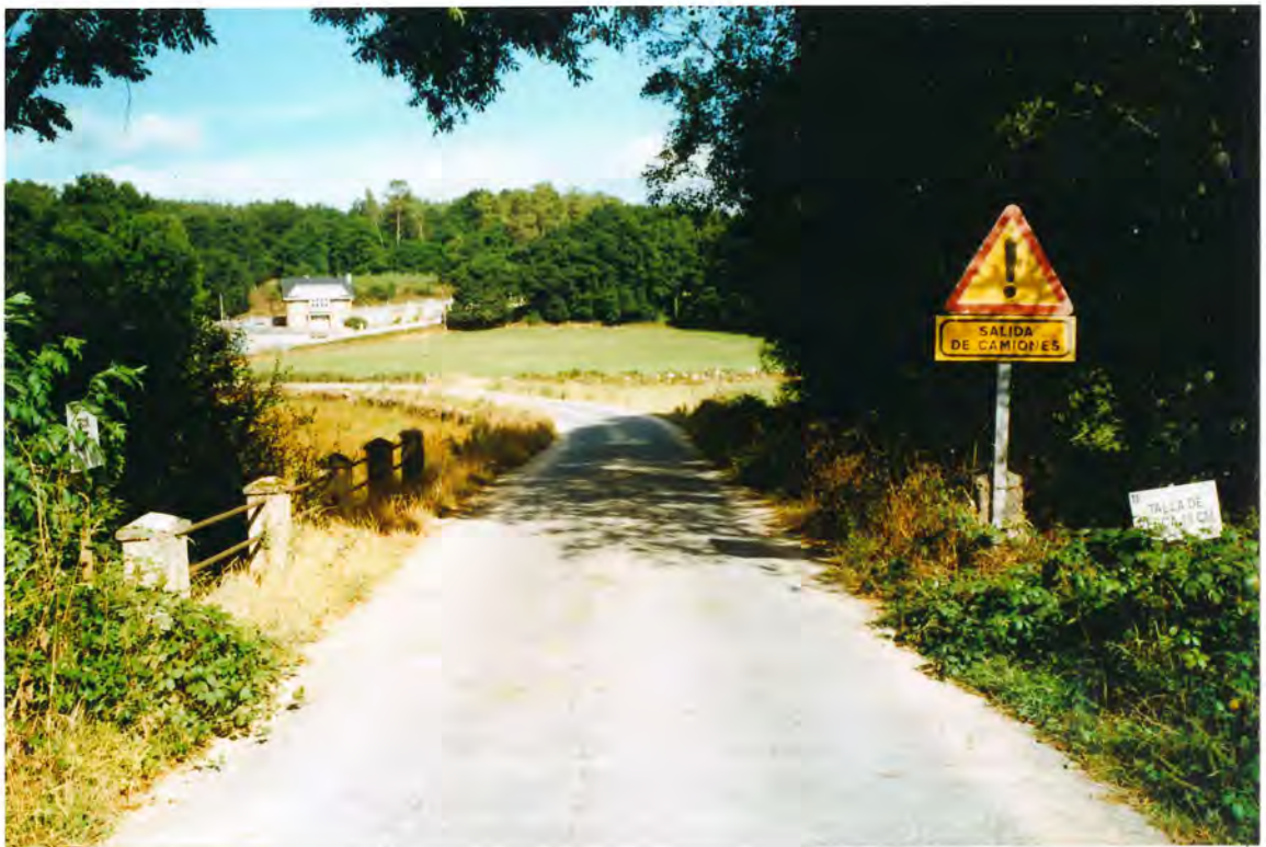
F.30. Carretera en el puente, sobre el río Tordea, en Franqueán
