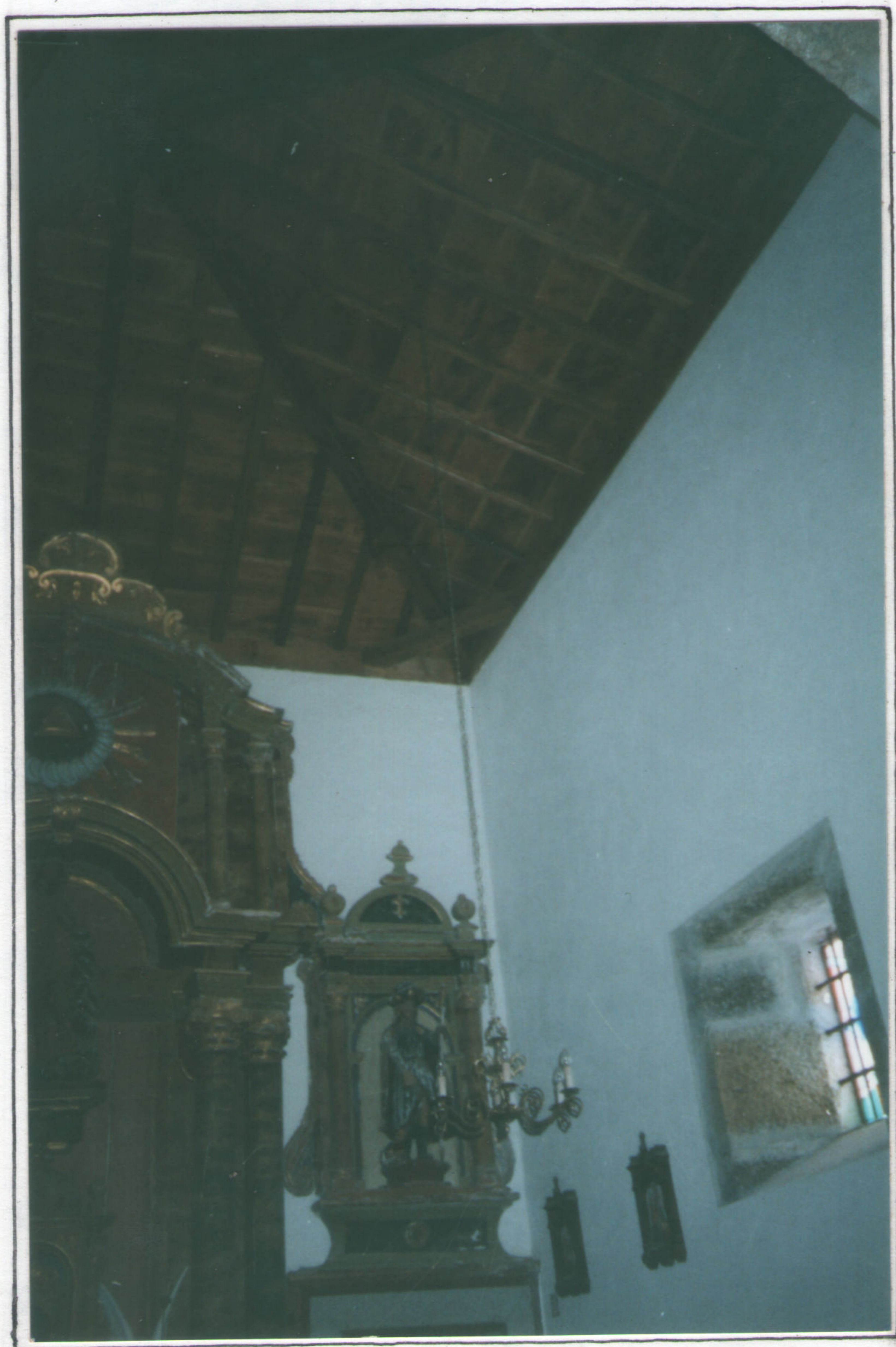
Detalle de la armadura de madera en el Presbiterio.
