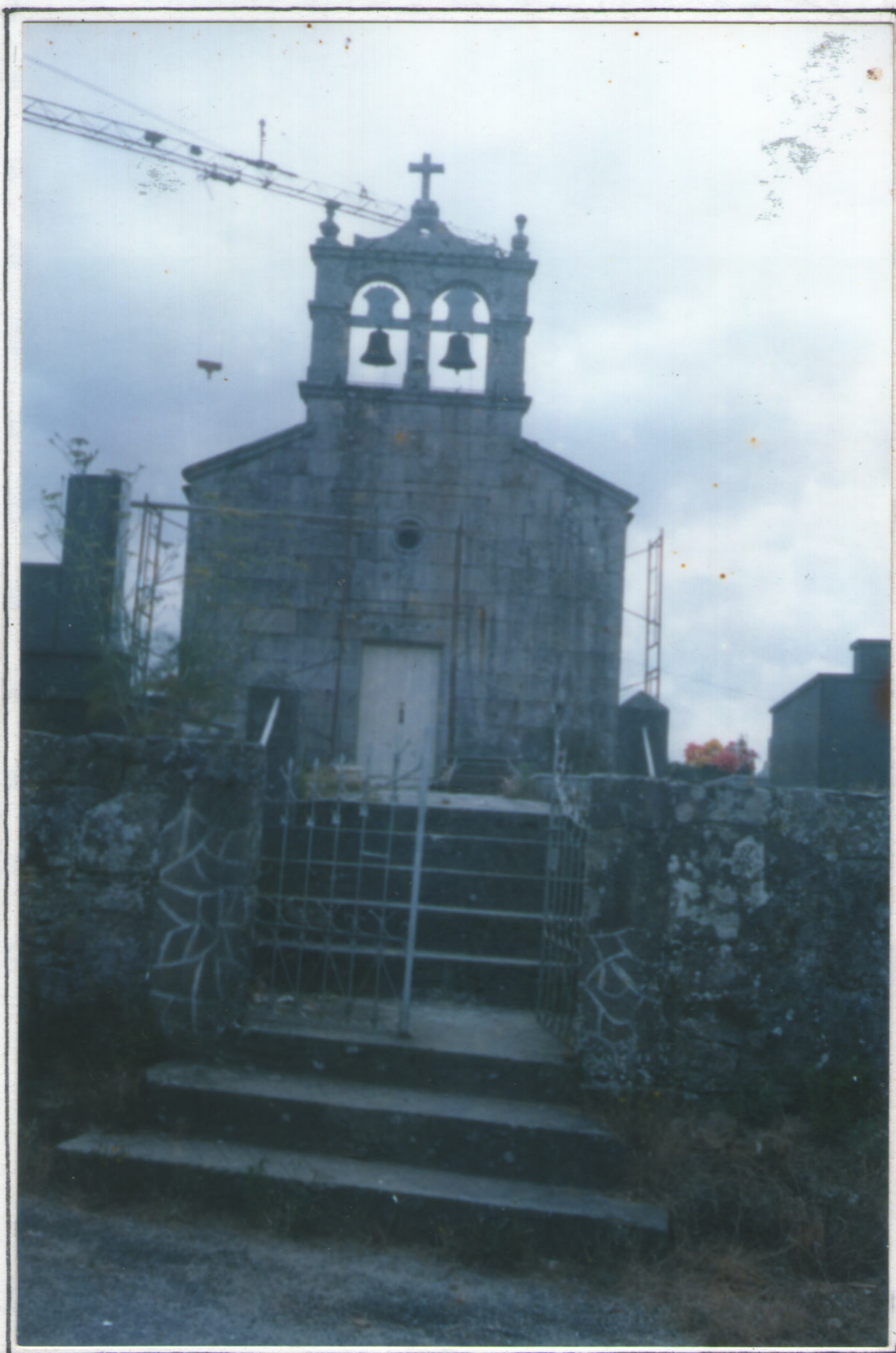
Escaleras del atrio antes de la reforma de 1.999.
