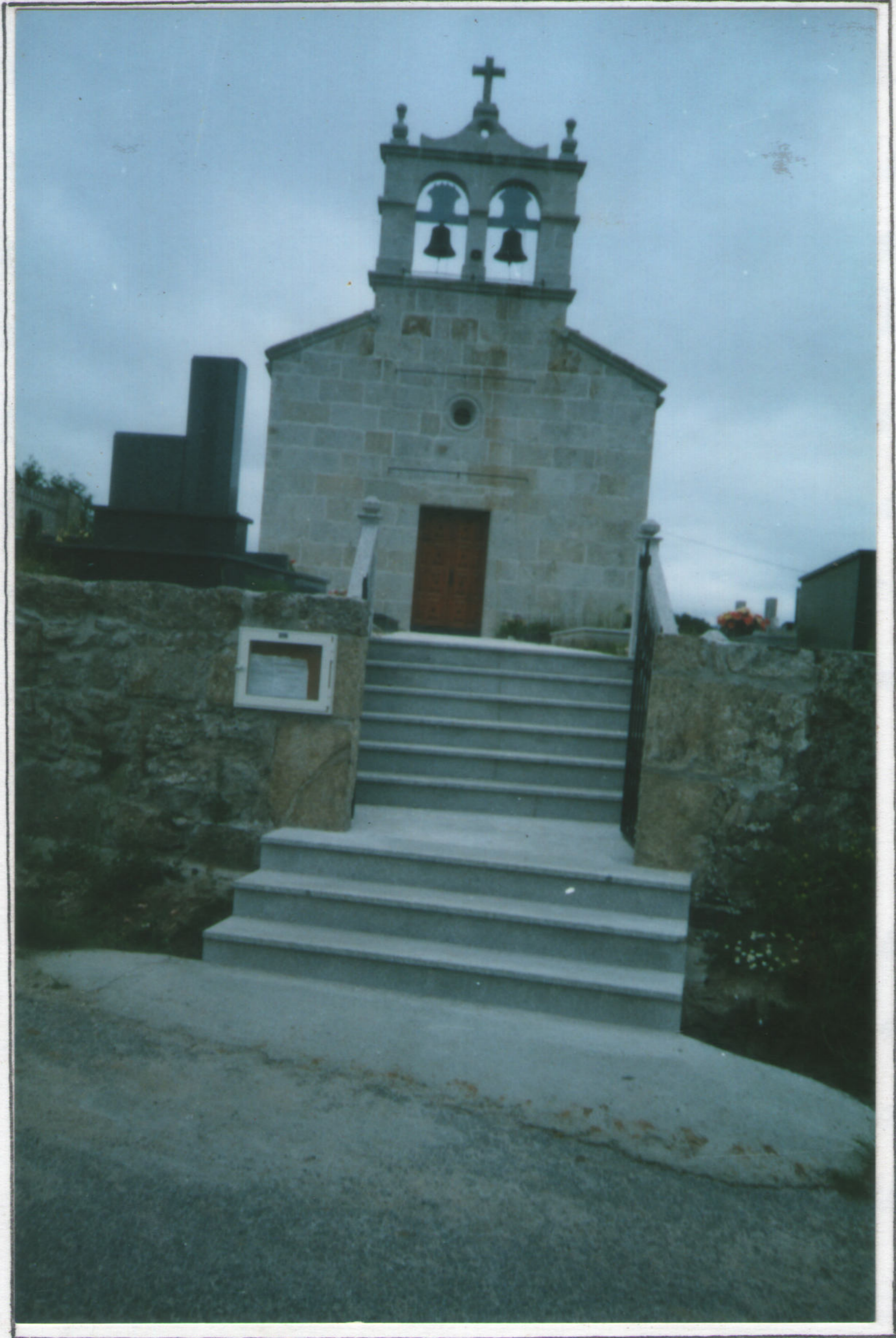
Actual fachada principal
