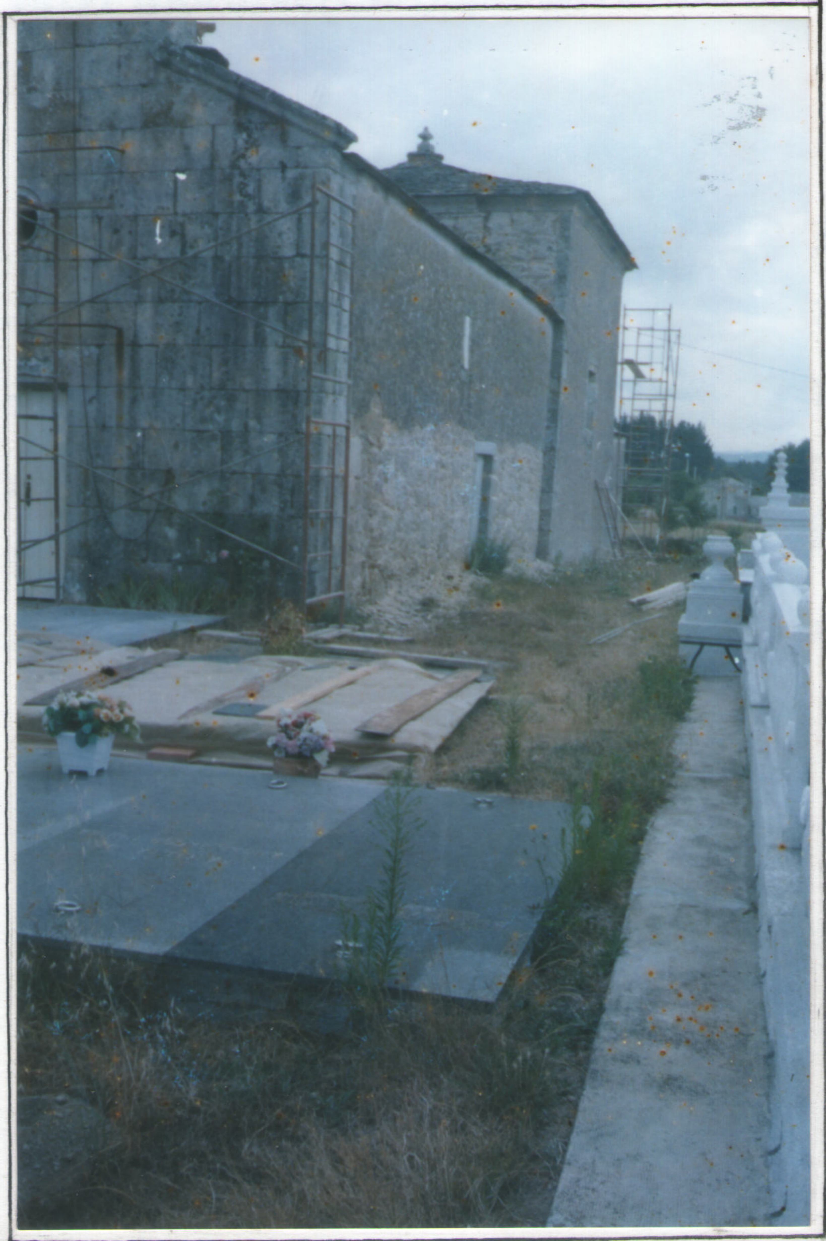
Obras en la fachada Sur
