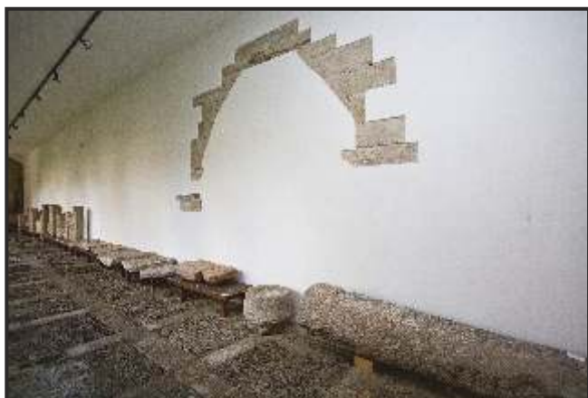
Foto 04. Claustro de MPL despois da intervención
