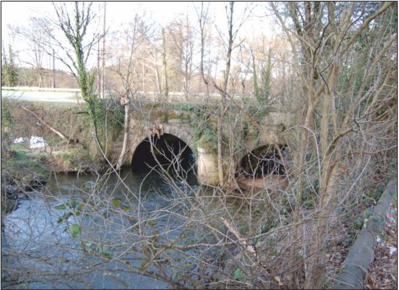
Lám. 10. Ponte Vella de Gomeán
